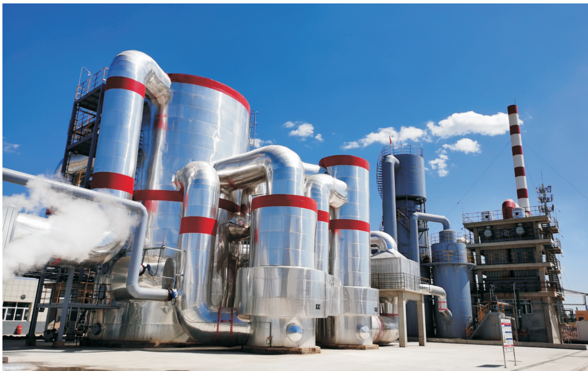
宁夏中泰富瑞30万吨硫磺制酸装置
