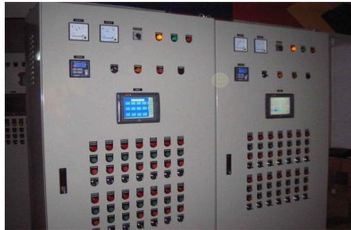
图 6. 中频煅烧炉电能控制箱
